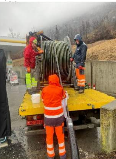
NS Kabelzug mit Verlegefahrzeug
