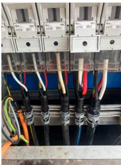
Anschluss an NS Verteilung / TS
