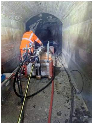
NS Kabelzug über Kabelhund
