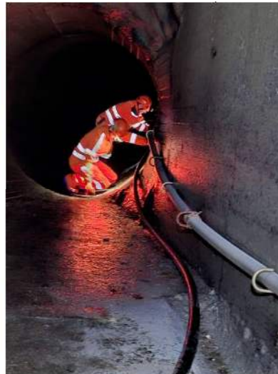
Montage PE Rohr an Stollenwand
