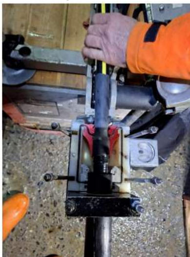
Pressen von zwei Kabelstücken
