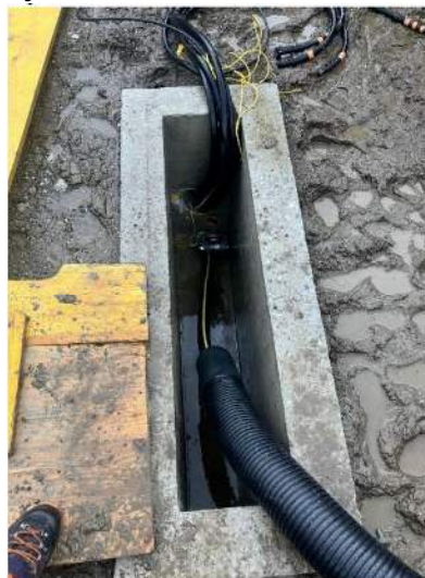
Verlegung in Kabelvorschacht
