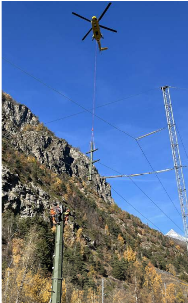
Montage eines neuen Strommasts 16kV Freileitung Ackersand - Kalpetran
