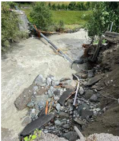
Heruntergerissenes Stahlrohr/ MS Kabelzuleitung zu Jungbachtal
