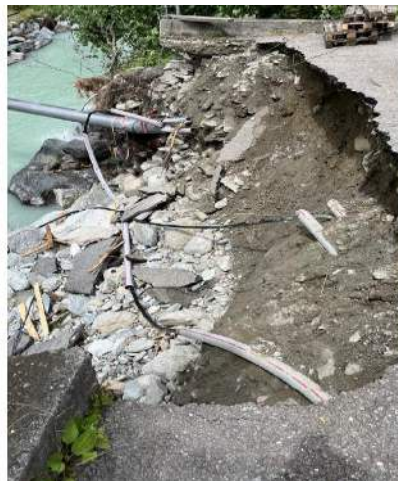
Heruntergerissenes Stahlrohr/ MS Kabelzuleitung zu Jungbachtal
