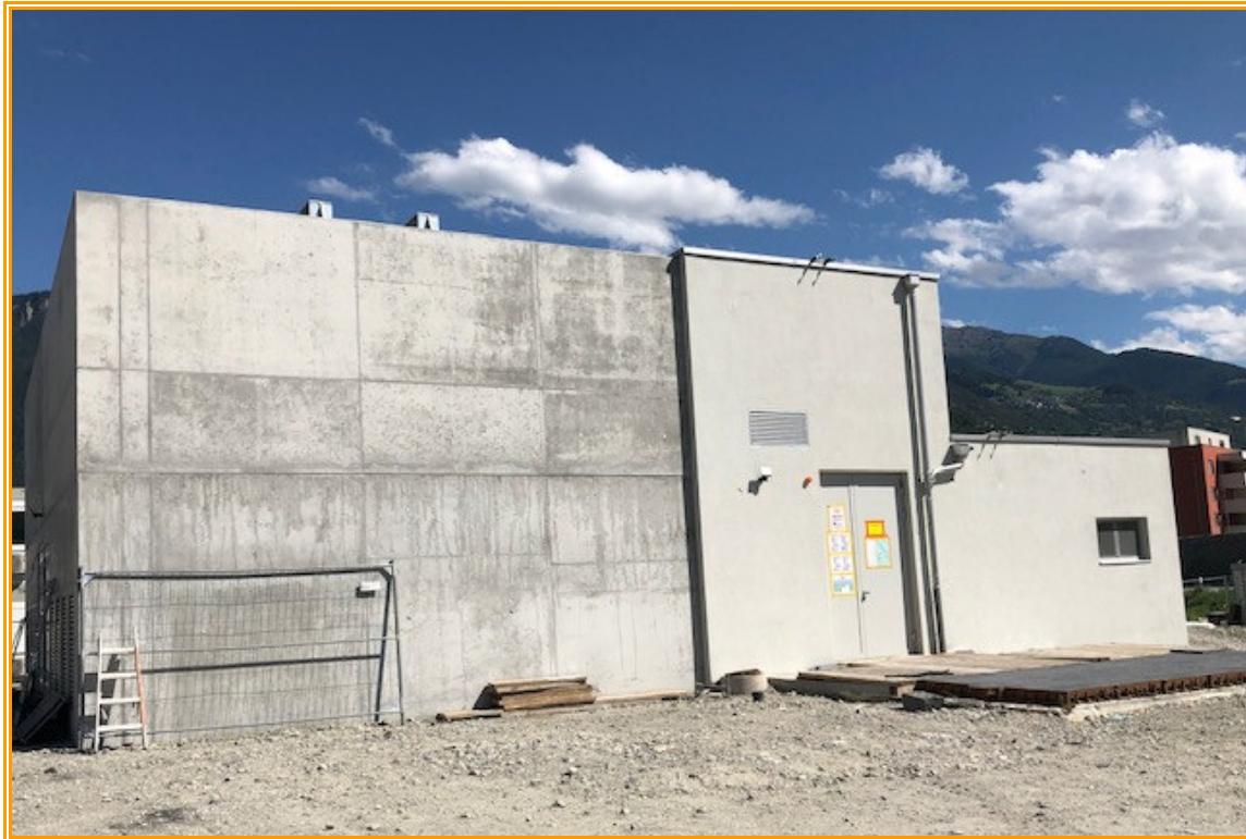
Neues Unterwerk Visp
