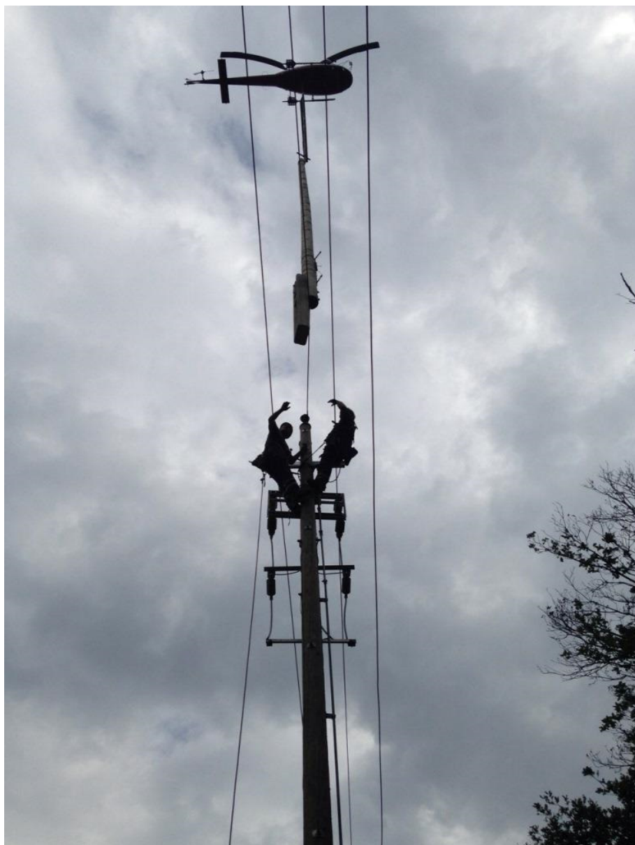
Montage eines Endmastens für die 16kV Einspeisung Tunnel Eyholz
